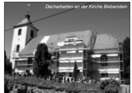
Dacharbeiten an der Kirche Bieberstein
