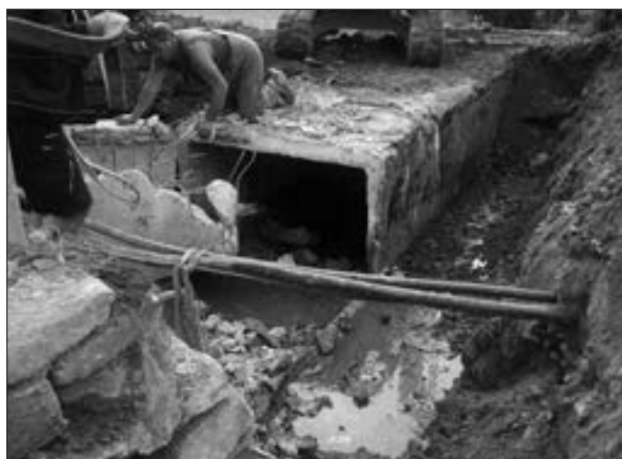
Abbrucharbeiten alter Durchlass
