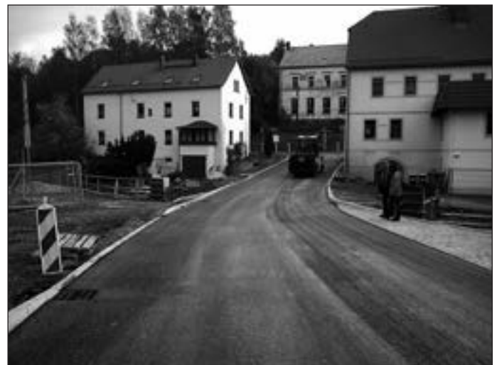
Einbau der Asphaltdecke
